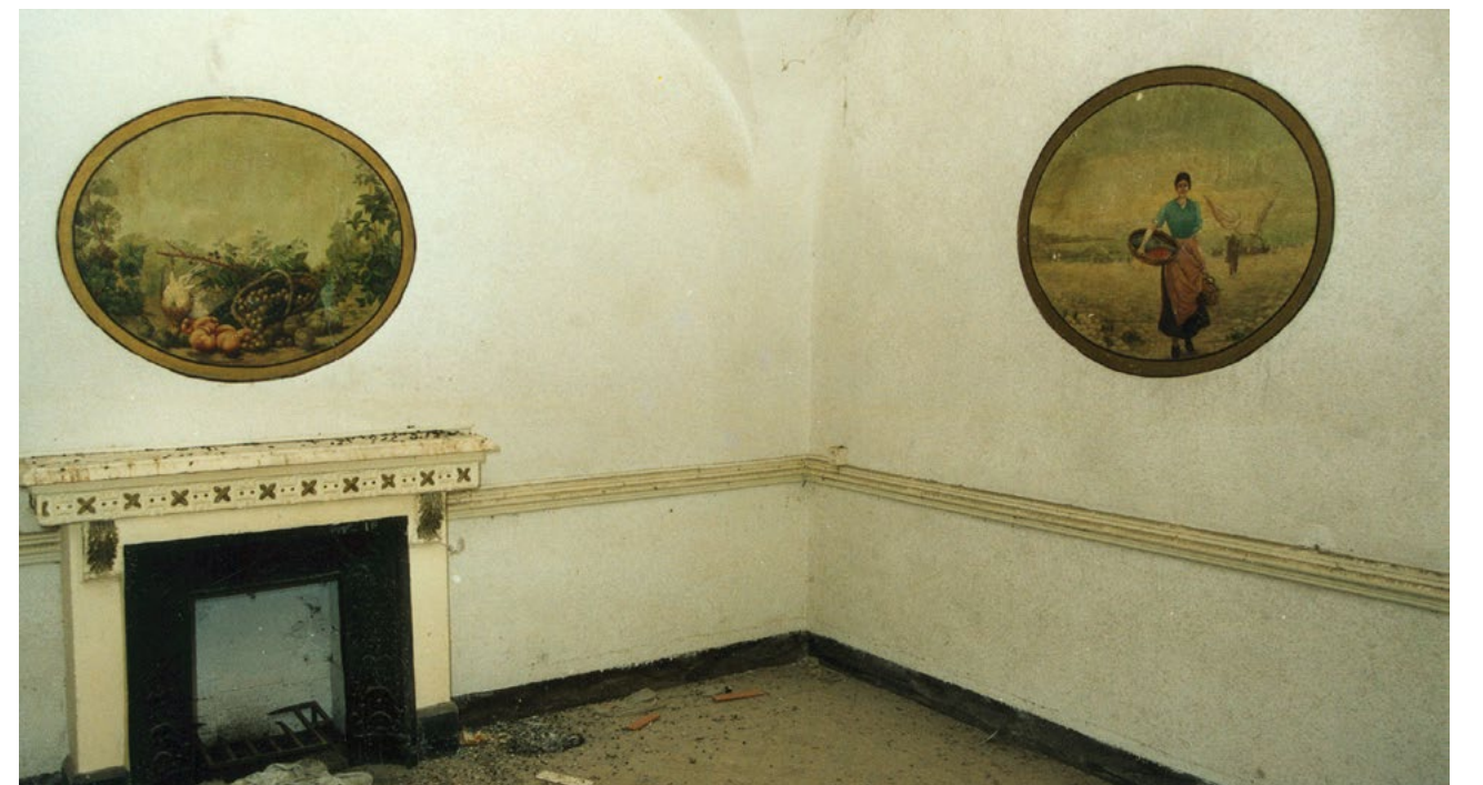
Detall d'una cambra de l'antiga casa Matlleria, situada a la plaça Nova, número 1, de Palafrugell, que l'any 2003 va ser enderrocada per construir-hi l'esplai EspaiCaixa per a la gent gran. Fotografia Paco Dalmau Fàbrega
