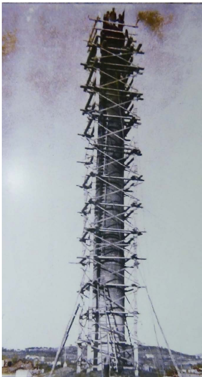
Xemeneia construïda pel mestre d'obres Jaume Casadevall Daussà. A la imatge hi podem veure com a la zona de la corona hi ha tres persones, possiblement operaris.
