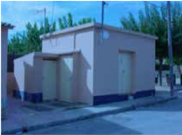
Estació de bombament de Mont-ras
