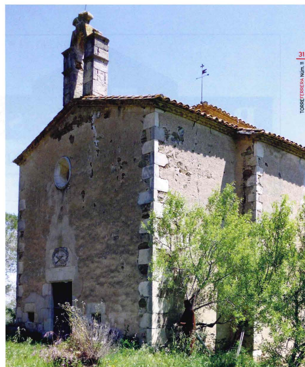
Detall de la façana del temple de Sant Llop, construït entre el 1749 i 1757.
